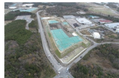
写真3-5-2 土壌貯蔵施設
