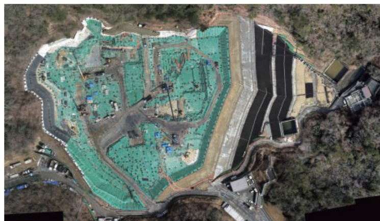
写真3-5-3 特定廃棄物埋立処分施設の様子
